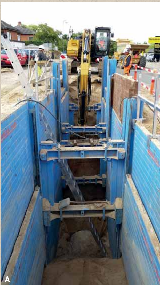
Figur 7. Stor kloakledning med grusfyld. A. Konstruktion af en \varnothing 2500 mm kloakledning i bunden af en 8 meter dyb ledningsgrav. B. Beliggenhed af kloakledninger med overliggende byggeri. Odense. De forskellige farver er udtryk for forskellige dimensioner/typer af ledningerne.
